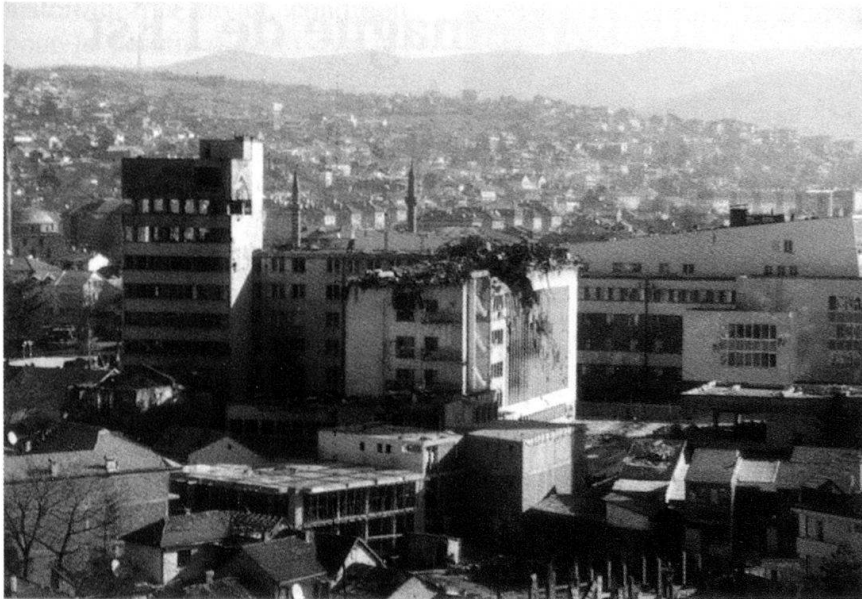
Un centre de télécommunications à Pristina (Kosovo) touché par un missile de croisière de l'OTAN.
