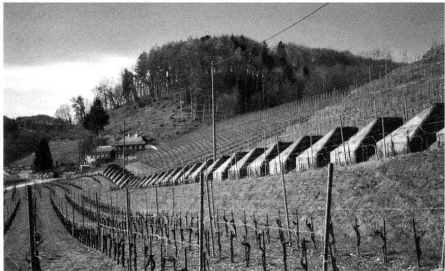
Barrage antichar «Terrains», secteur Sermaret.
