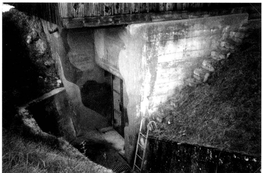
A656, Moulin de la Vaux. Ouvrage en sous-sol camouflé sous un baraquement de bois. La rampe d'accès.
