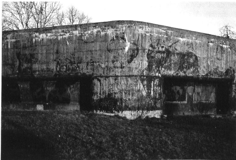
Ouvrage de Vich.
