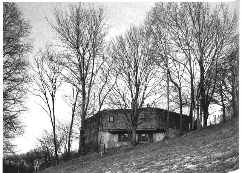
Ouvrage de Maison-Cézile.
