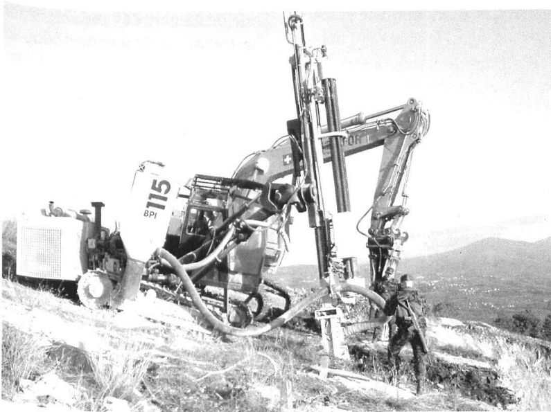
La SWISSCOY reste une formation logistique et dispose d'un parc de machines impressionnant.
