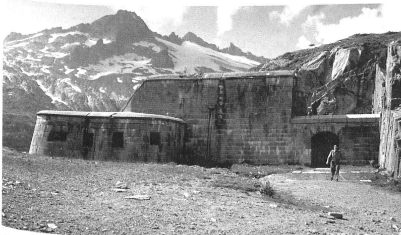
Batterie cuirassée de Galenhiitten, col de la Furka en Valais. (Photo: M.L.)
