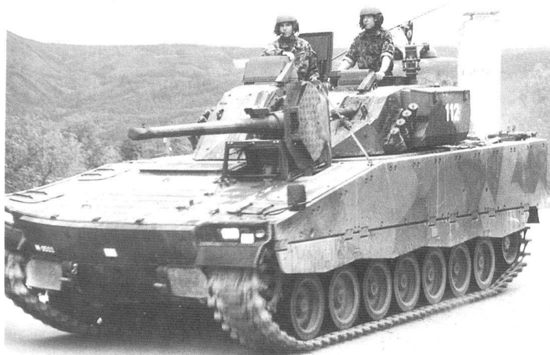
La version de série du CV-9030 suisse dispose d'une rampe arrière, de blindages additionnels, d'un châssis réhaussé, d'aménagements intérieurs sur mesure, et d'un bus de données couplé à un Battlefield Management System (BMS).
