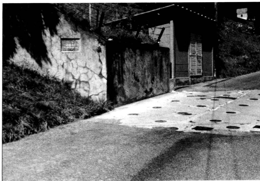
Plus de 15000 ouvrages ont été déclassés depuis 1995. Cela a des conséquences sur l'engagement et l'organisation des gardes-fortifications. Ici, un barrage antichar de la Seconde Guerre mondiale près de Corbeyrier.
