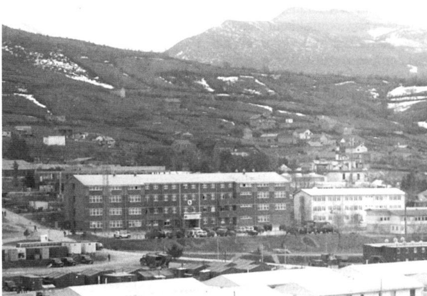
Vue aérienne du bâtiment principal de l'EM MNBS à Prizren.
