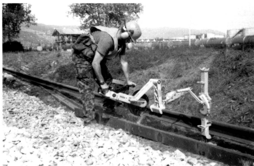
Travail à l'aide d'une poulie découpeuse à benzine selon les prescriptions de la CNA.
