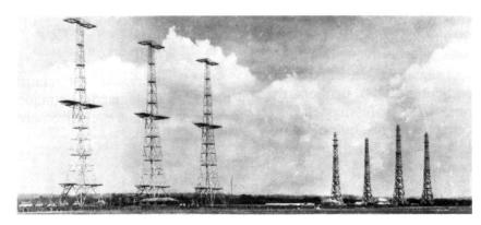
Ces tours constituent l'une des quelque 20 stations radar surveillant la côte Est de l'Angleterre en 1939. Les trois pylônes de gauche sont coiffés d'antennes émettrices de micro-ondes capables de capter un appareil à plus de 170 kilomètres et d'en renvoyer l'écho sur les pylônes de droite. Un technicien radar repère la direction de l'ennemi, permettant à la R.A.F. de lancer des chasseurs à sa poursuite. Il n'y
