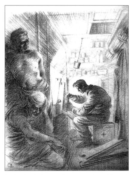
A la base du puits d'accès, le dépôt-atelier où des spécialistes préparent les étais, les rails et les conduits de ventilation du tunnel au fur et à mesure de son avancement. Au plafond, une boîte de conserve pendue au bout d'une corde et remplie de cailloux. Dès que la corde est agitée depuis le haut, le bruit provoqué alerte les occupants du tunnel qui remontent au plus vite. A gauche, deux officiers récupèrent avant de remonter à l'air libre.
