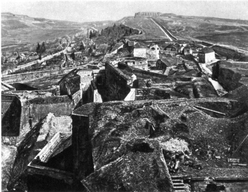
Le fort de la Justice et la tour des Bourgeois vue depuis la terrasse du Château.
