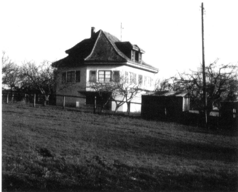
Bon exemple pour le camouflage d'un fortin.
