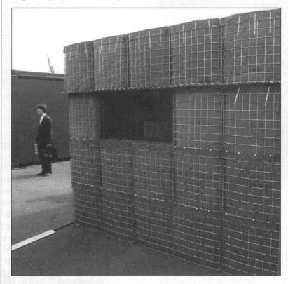
Le *Concertainer* se présente sous la forme d'une chaîne de bacs en treillis d'acier et de toile que deux hommes peuvent aisément déplier, puis remplir à l'aide d'une pelleteuse, soit 20 minutes pour 10 m x 1 m de gabions.
