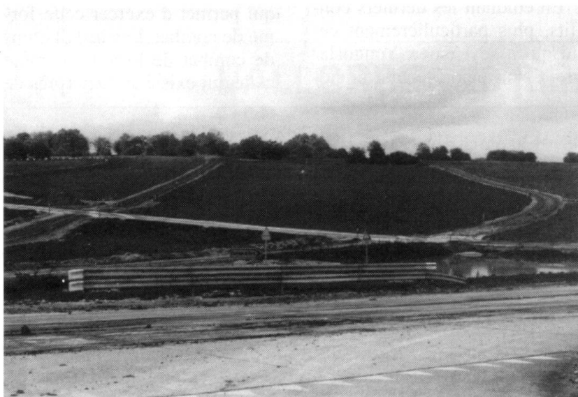
Des pistes ont été aménagées pour les blindés afin de ménager le terrain et l'environnement.
