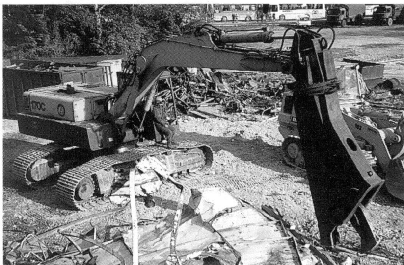
Pour travailler dans les décombres, il a fallu faire venir en renfort des machines de chantier d'une entreprise civile française (Photo : H.W.).
