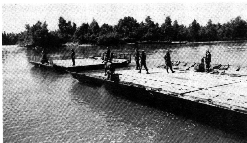
Les modules sont assemblés entre eux (3 en général) pour former un ensemble poutre. (Photo Jean Mayet)
