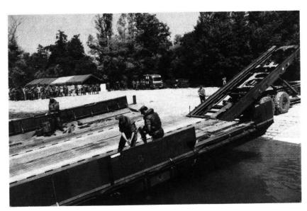
La partie basculante de la semi-remorque s'incline. Le module est mis à l'eau. Les moteurs hors bord sont installés. (Photo Jean Mayet)
