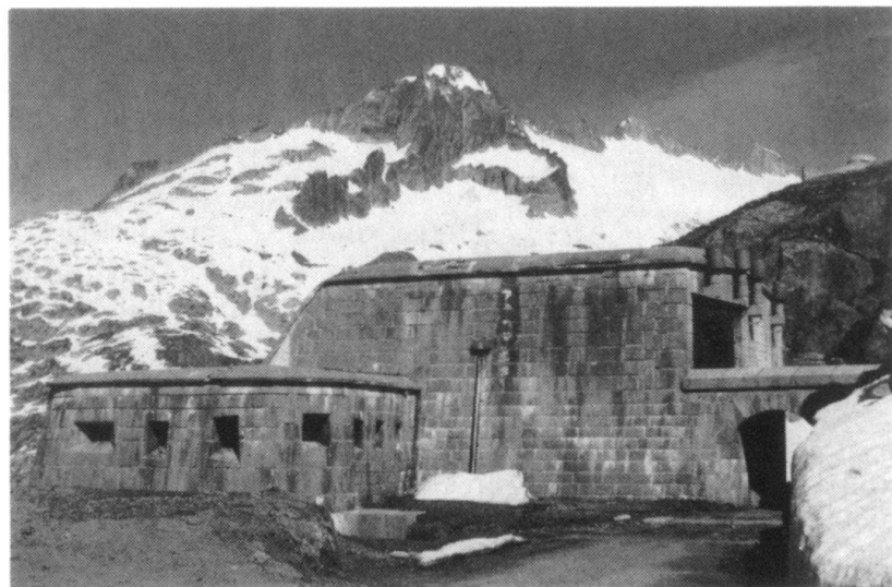
Fort de Gallenhütten. La porte d'entrée protégée par une caponnière. En haut, à droite, la cloche d'observation.
