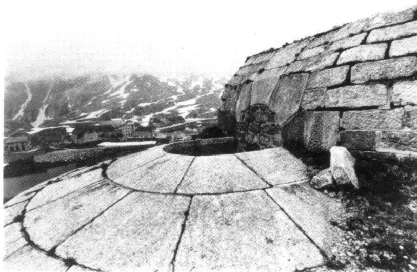
Front sud de la redoute de l'Hospice, placée devant le casernement supérieur. En arrière, les immeubles du sommet du col.
