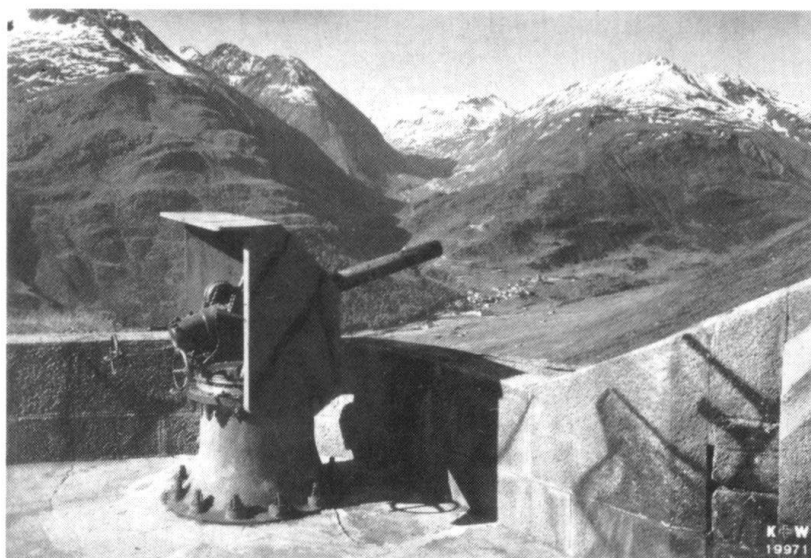
Canon de 8,4 cm sur affût à pivot central (dit «à crinoline») dans le voisinage immédiat du fort Bözberg. En arrière, le village de Hospenthal et la route du Saint-Gotthard.
