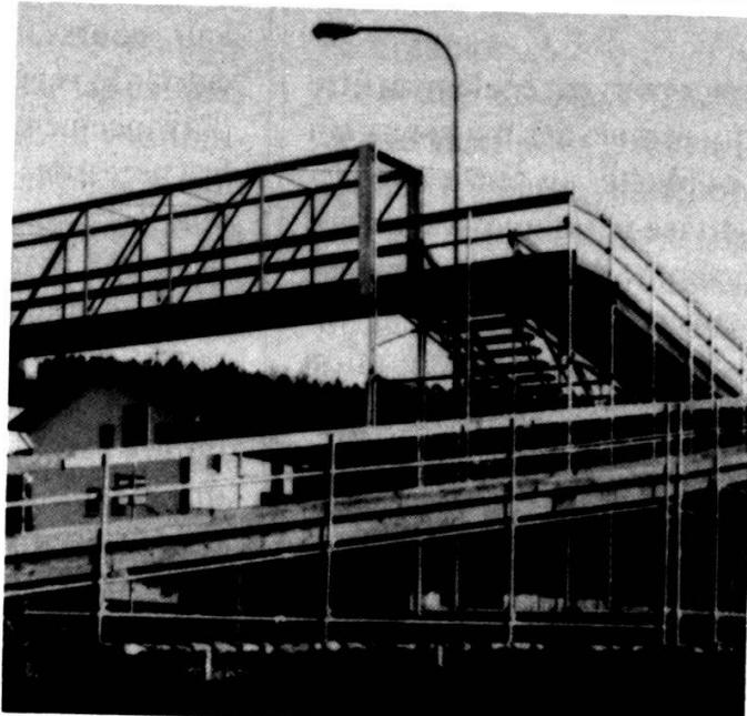
Nüssli-Construvit – un concept pour les ponts de service, passerelles provisoires et passerelles, avec différentes possibilités d'utilisation.
