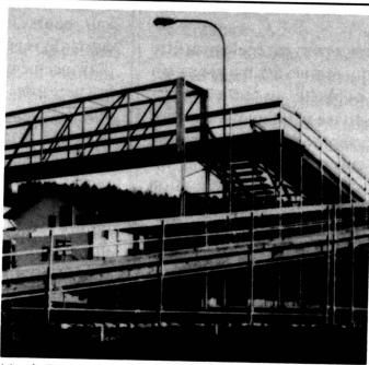
Nüssli-Construvit – un concept pour les ponts de service, passerelles provisoires et passerelles, avec différentes possibilités d'utilisation.
