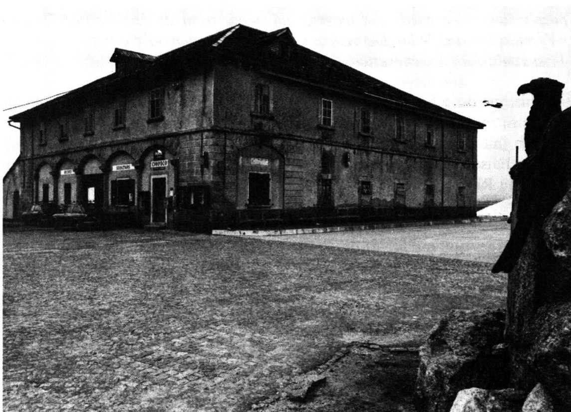
La «Vecchia Sosta», où le futur Musée du St-Gothard sera aménagé, avant la restauration de 1983-84 (photo Théo Frey).
