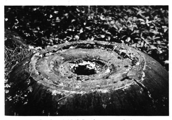
Coupole percée à l'aide d'une charge creuse appliquée.
