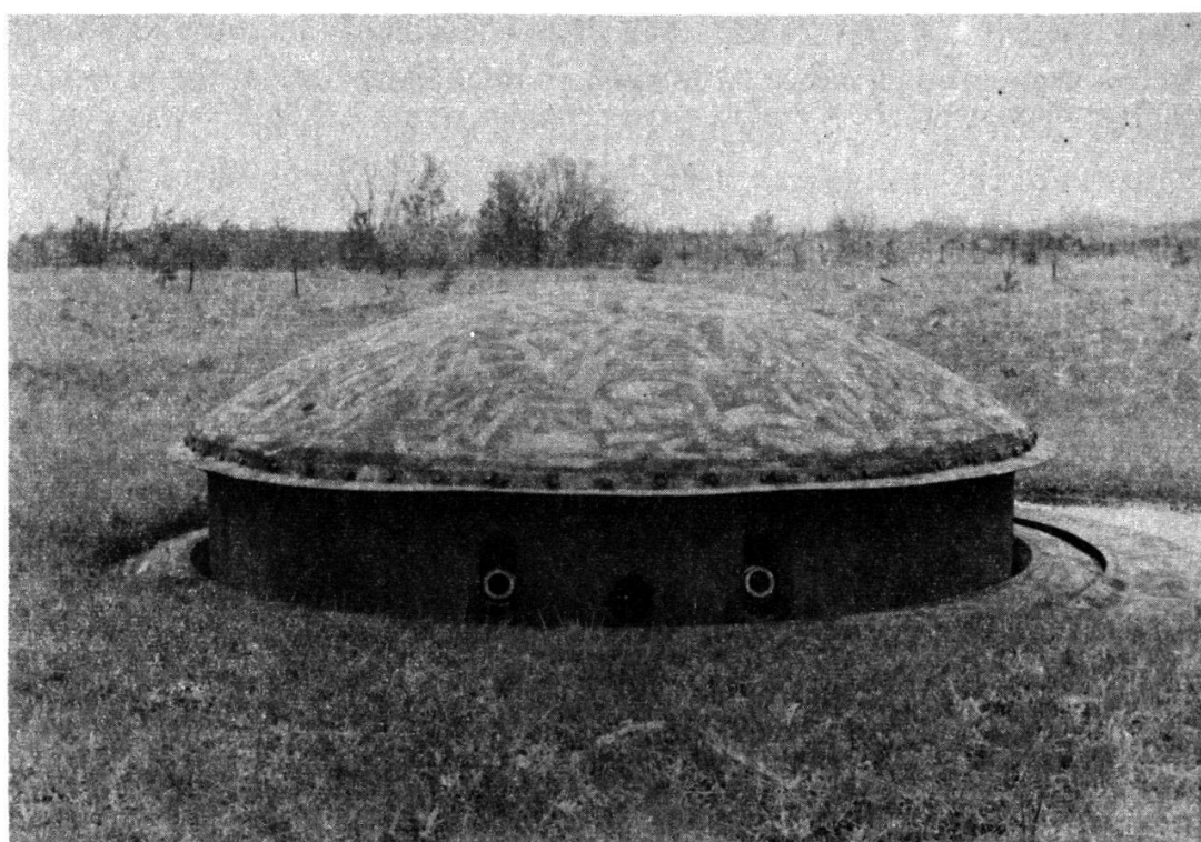
Fig. 3: Tourelle de 75 à 2 tubes, modèle 33. Portée max. 11 800 m. 24 coups/minute. La tourelle est ici en position de tir. Eclipsée, elle offre une excellente protection à ses tubes. Le mot d'ordre de l'artillerie de forteresse française semble être: «Aucune volée extérieure! Toutes les armes sous protection blindées!» Si l'on songe que la fortification Maginot est née des enseignements tirés de la Bataille de Verdun et de son déluge de feu, on comprend mieux cette conception de protection quasi absolue!
