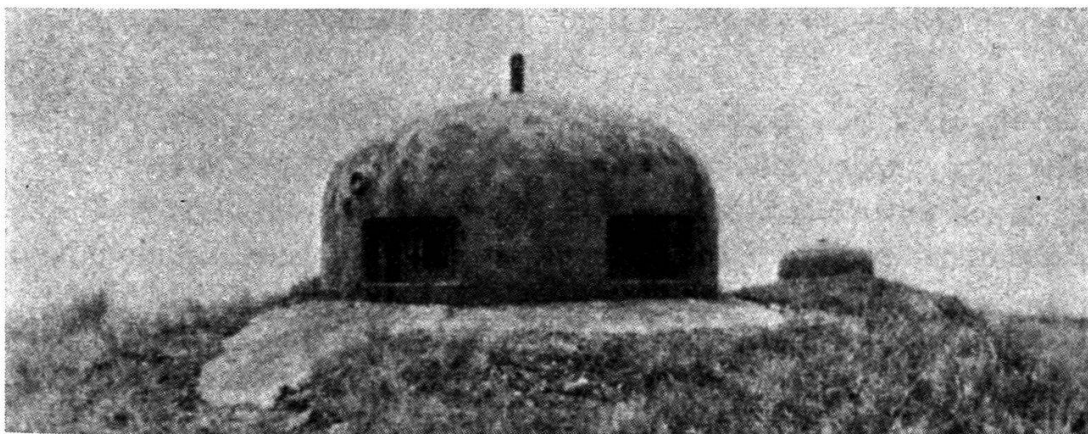
Bloc 6, cloche de guetteur en liaison avec le PC d'infanterie de l'ouvrage; 1 épiscopie et 1 mortier de 50 mm en place dans les créneaux. A l'arrière, cloche d'observation d'artillerie.
