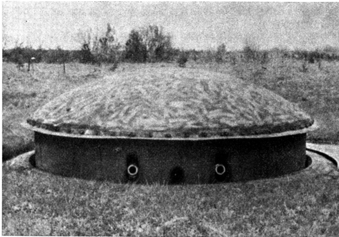
Simserhof: Bloc 8, tourelle de 75 mm, modèle 33, en batterie. ( L. Claudel: op. cit., p. 47 )
