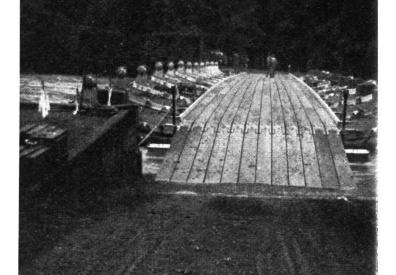
4. Le pont flottant terminé permet le franchissement de véhicules de 50 t.
