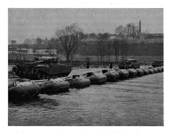
Fig. 5. — Pont sur appuis flottants, capacité 50 t.
