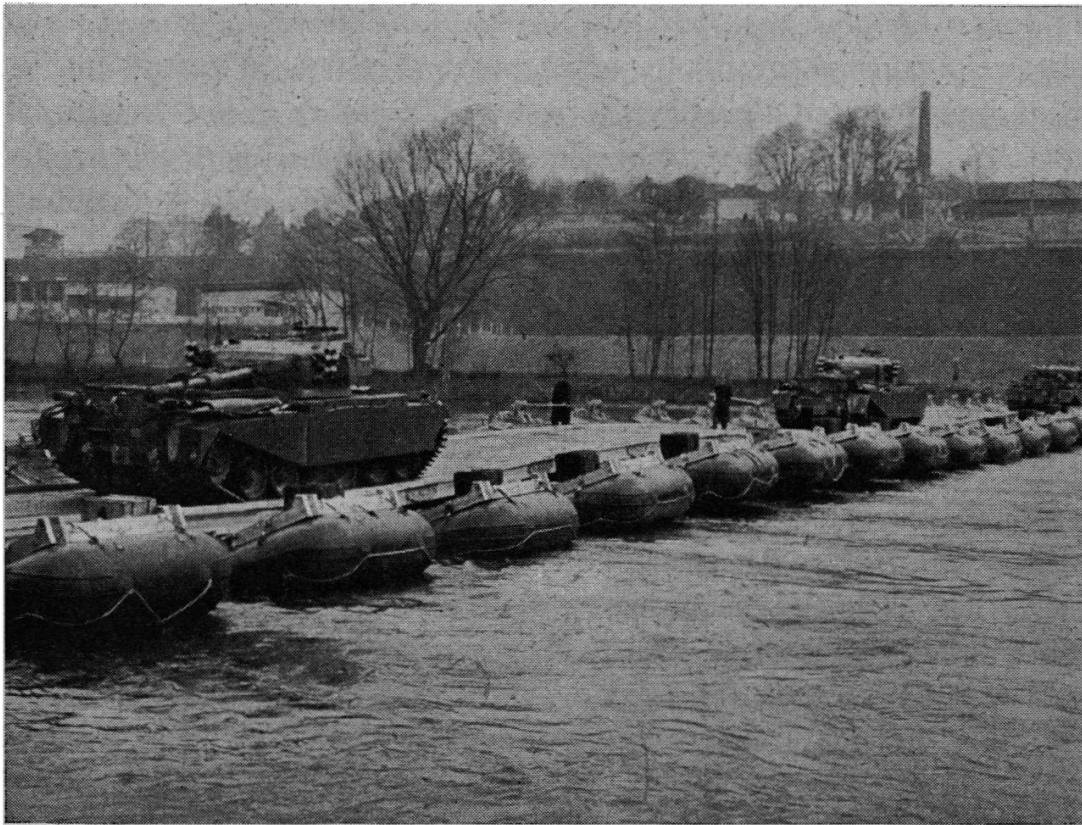
Fig. 5. — Pont sur appuis flottants, capacité 50 t.
