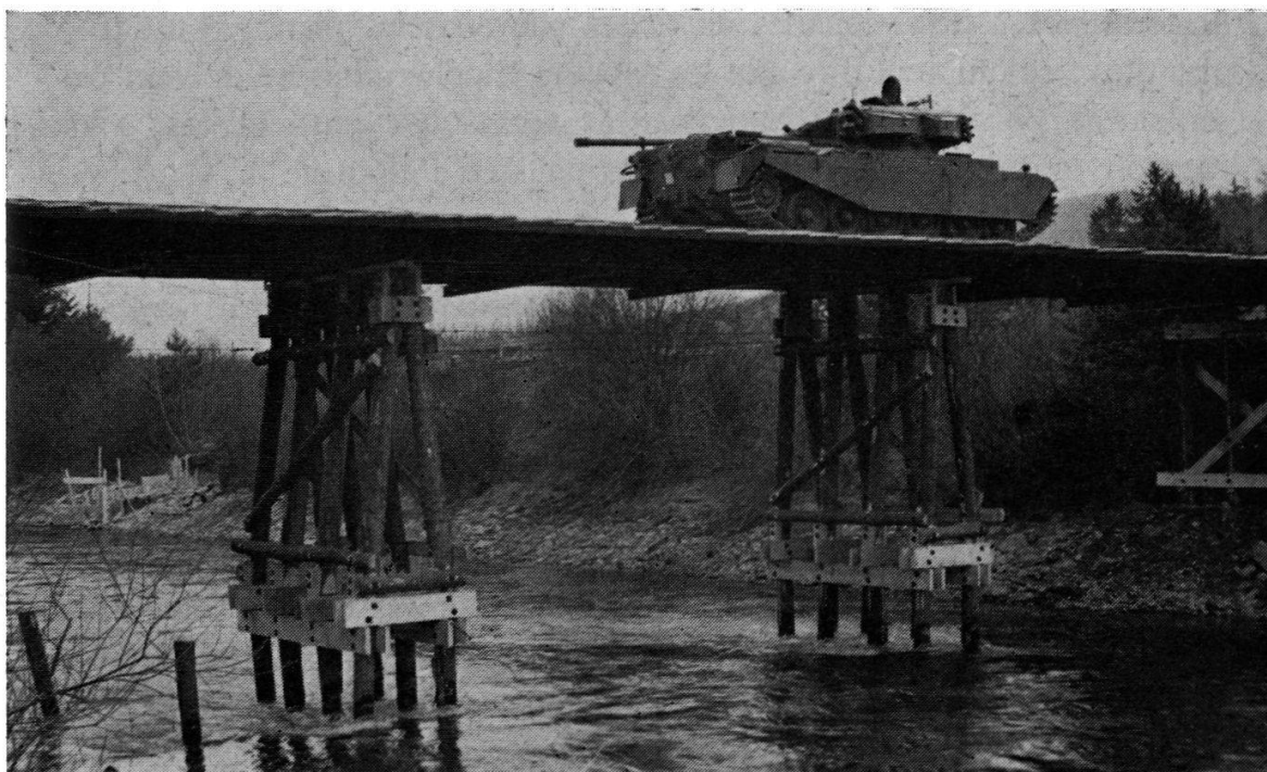
Fig. 6. — Pont de fortune (DIN), capacité 50 t.
