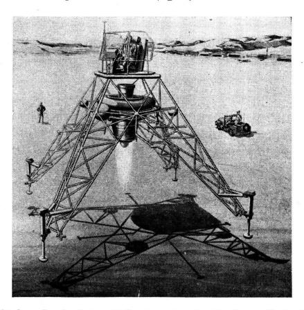
Fig. 3. — Le simulateur d'atterrissage lunaire (Air Revue février 63)
