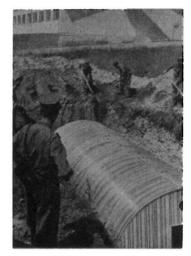
Fig. 6. — Mise en place d'un abri-tunnel.
