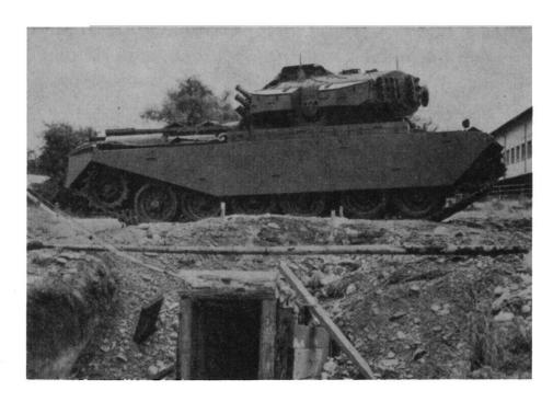
Fig. 7 a. — Essai de charge par le passage d'un blindé transversalement au tunnel.
