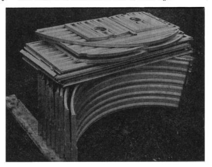
Fig. 5. Empilement du matériel pour un abritunnel de 4 m.
