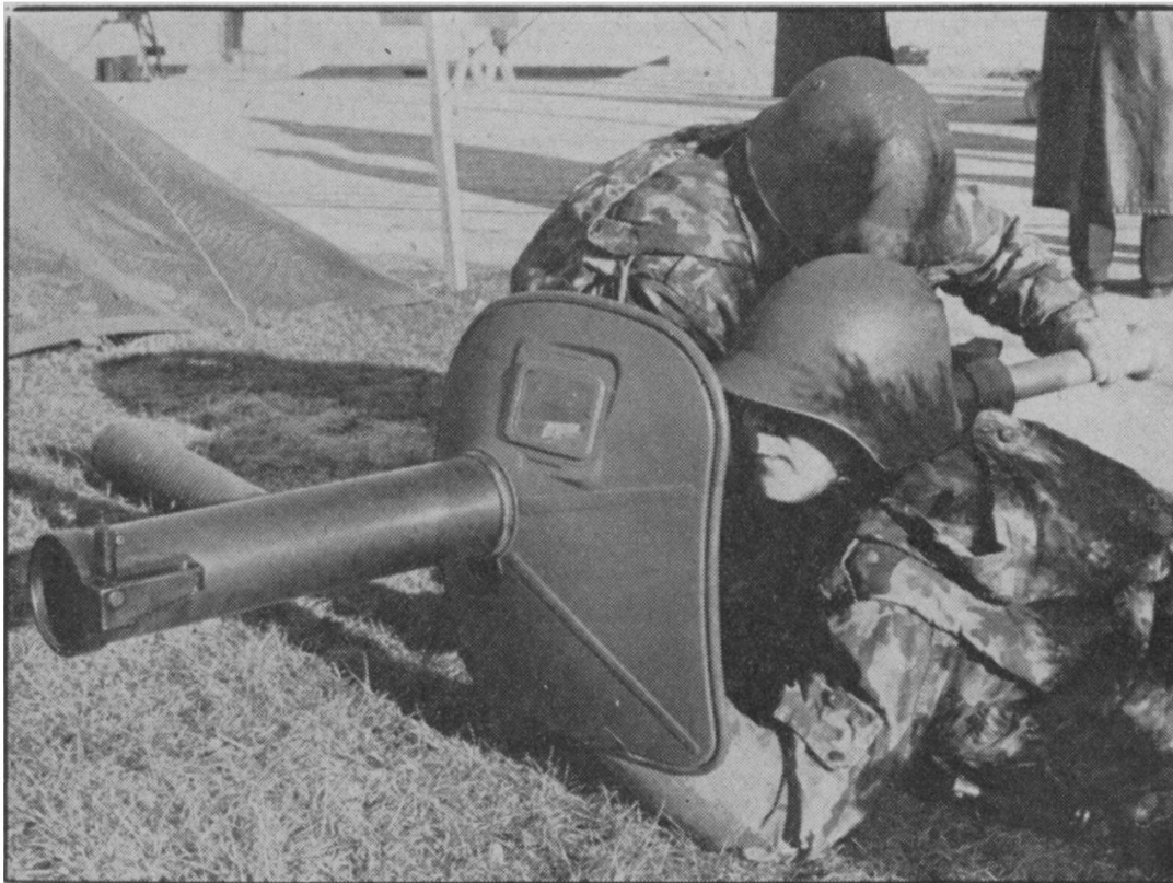
Fig. 2. — Le tube-roquette 58 servi par deux hommes dont l'un introduit un projectile
