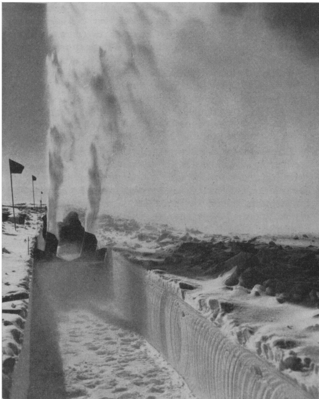
Machine à tailler la couche de glace ou de neige, en action au Groenland, en vue de l'installation d'un habitat en profondeur. ( Photo Usis. )
