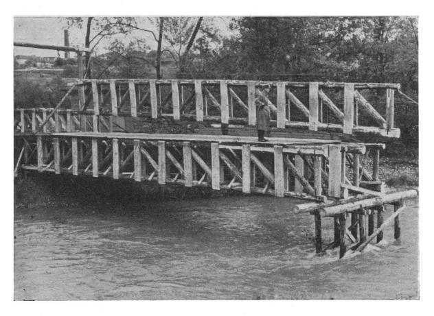
Fig. 2. — Mise en place d'une poutre à treillis en bois à l'aide d'un câble.
