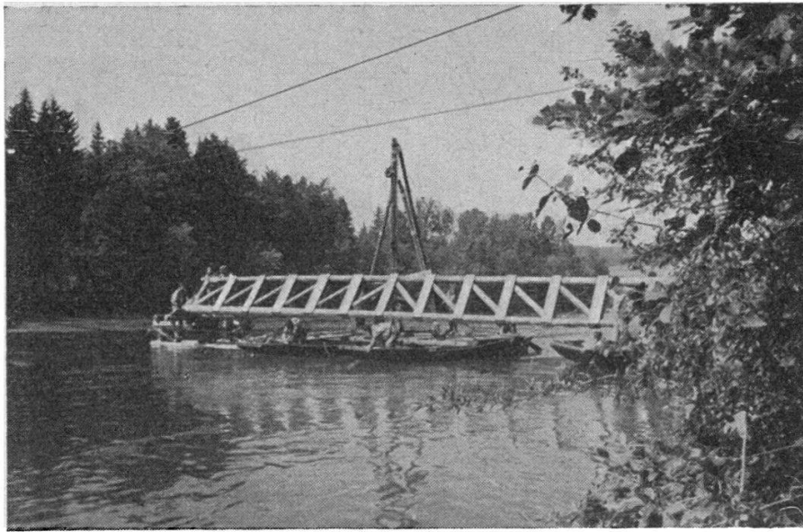
FIG. 3. — Mise en place d'une poutre à treillis à l'aide d'un bac. (Photo W. Kollros. Cliché Techn. Mitt.)
