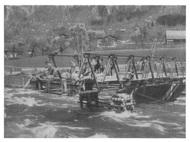
Fig. 6. — Montage du pont lourd d'ordonnance en acier par la méthode « en porte-à-faux ». La double palée de pilotis sert d'échafaudage auxiliaire.
