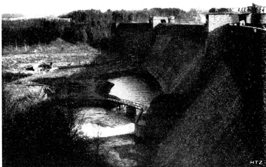
Etat actuel du barrage de la Möhne vu d'aval. La brèche, qui se situait entre les deux tours, n'est presque pas visible. A gauche, la tache claire, au pied de la forêt, marque l'emplacement de l'usine hydroélectrique ; on distingue des restes de la conduite forcée alimentant l'usine. Le lac, au pied aval du mur marque la fouille creusée par le déversement des eaux.
