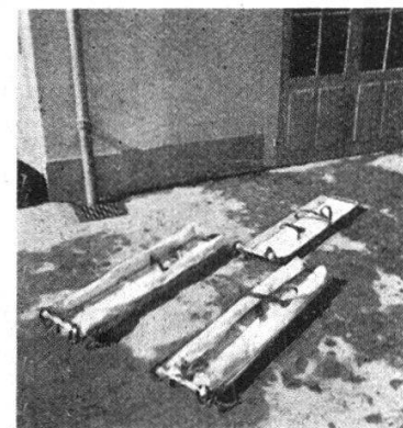
FIG. 12. En position de tir. Articulations et courroies, au centre du lugeon, pour fixer le trépied.
