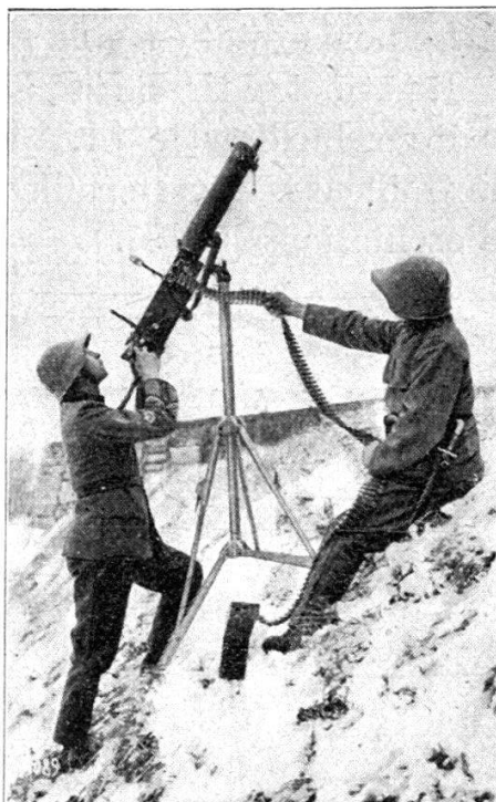
Fig. 5. Mitrailluse sur affût spécial pour le tir contre avions. La mitrailluse est munie du correcteur, de la crosse et du cache-flammes.
