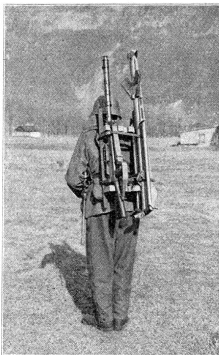
Fig. 2 et 3. Si l'arme doit être instantanément prête à ouvrir le feu, le F.M. est porté comme le montre la fig. 2. Dans le cas contraire, on sépare le F.M. de l'affût.
