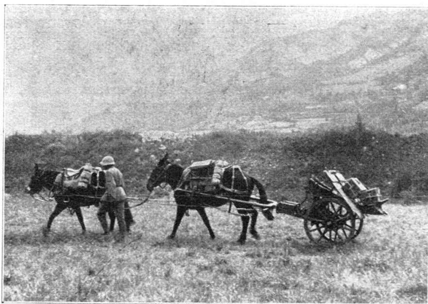
Canon de montagne 75 mm. (Modèle Bofors.) La « voiture-affût. »
