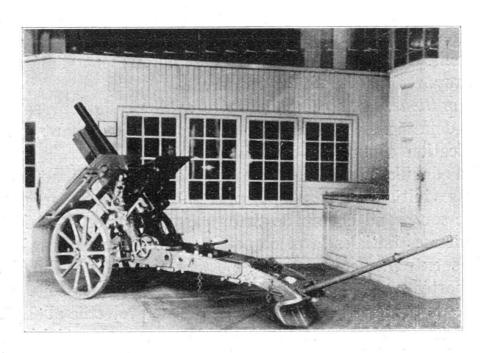
Canon de montagne de 75 mm. (Modèle Bofors.) Elévation maximum.
