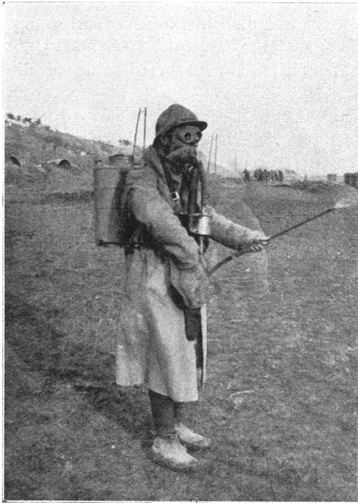
Un désinfecteur muni de son appareil pulvérisateur pour asperger, avec une solution neutralisante, les abris et endroits contaminés.
