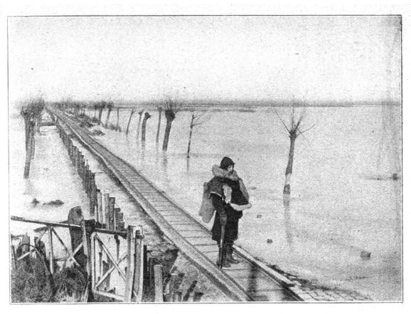
Route transformée en passerelle sur l'inondation. Une voie Decauville y est installée.
