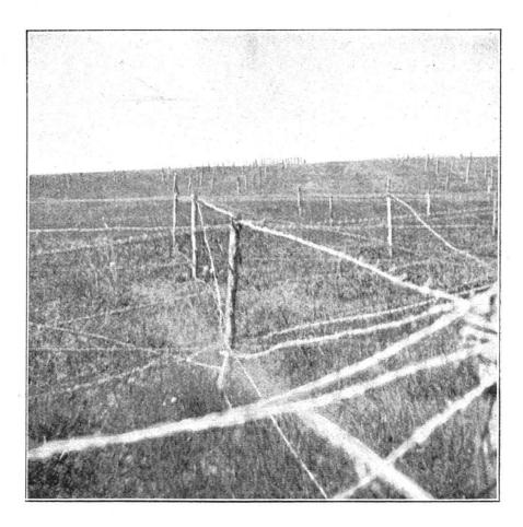
Réseau de fils de fer barbelés devant un point d'appui de 1<sup>re</sup> ligne (zône centrale en cerceau).
