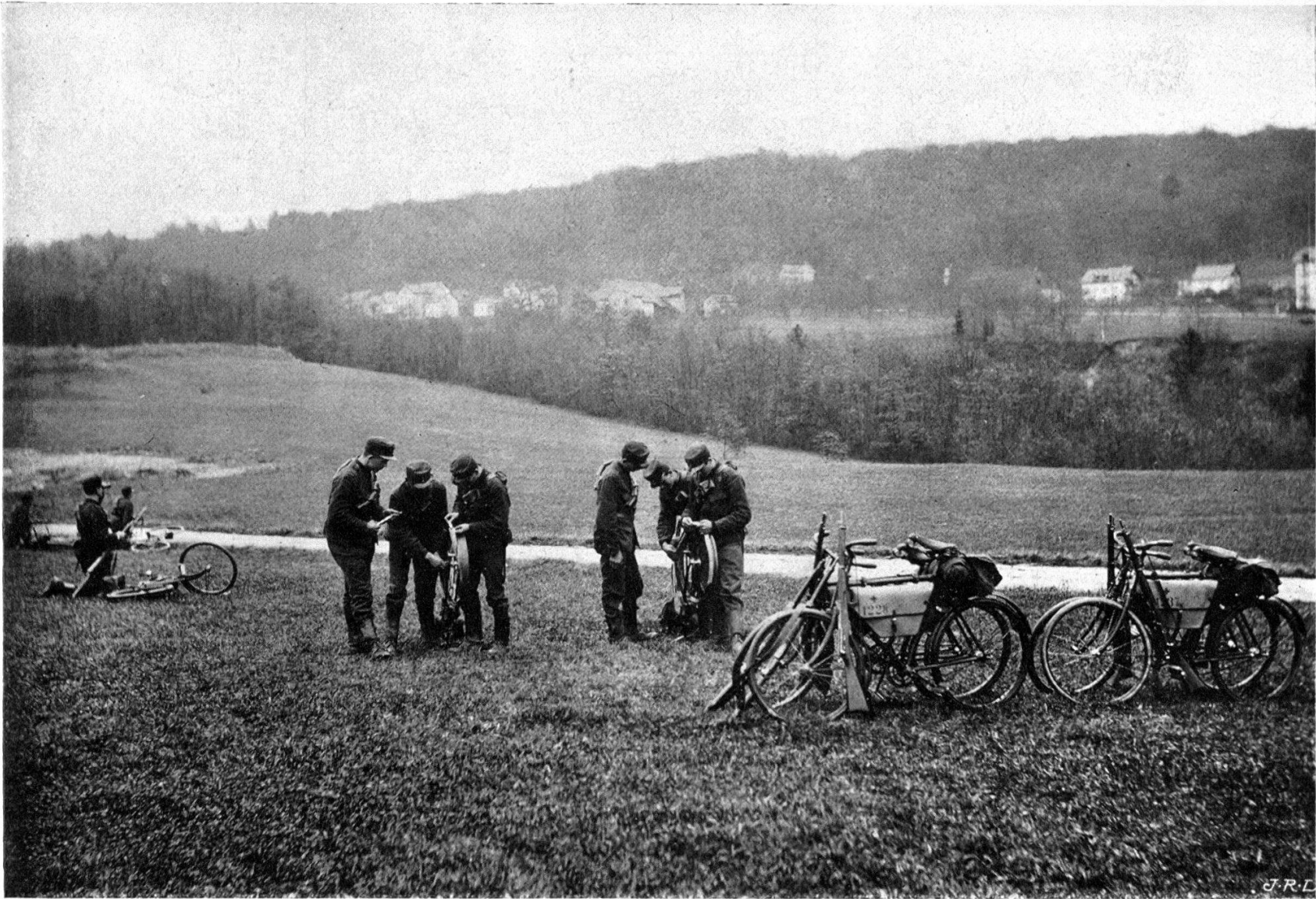
Réparations en cours de route.
