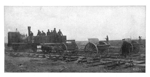
Fig. 12. — Un obstacle formé de rails de chemin de fer transversaux sur la piste de roulage de Meppen.
