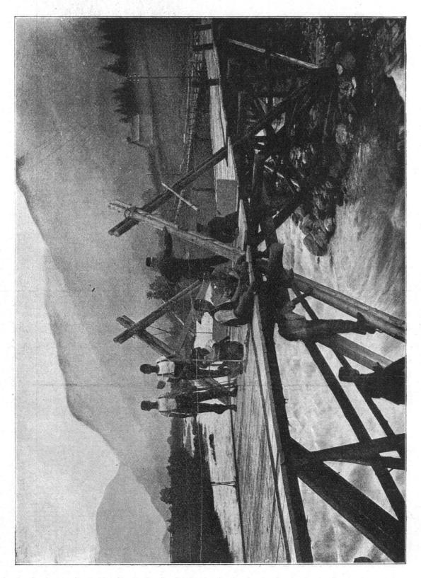
2. **Rambach**. Pont sur la Muota. Largeur de la voie: 4.5 m. Travées: 19 m. + 5.5 + 5.5 + 5.5 + 5.5 + 5.5 = 41 m.
