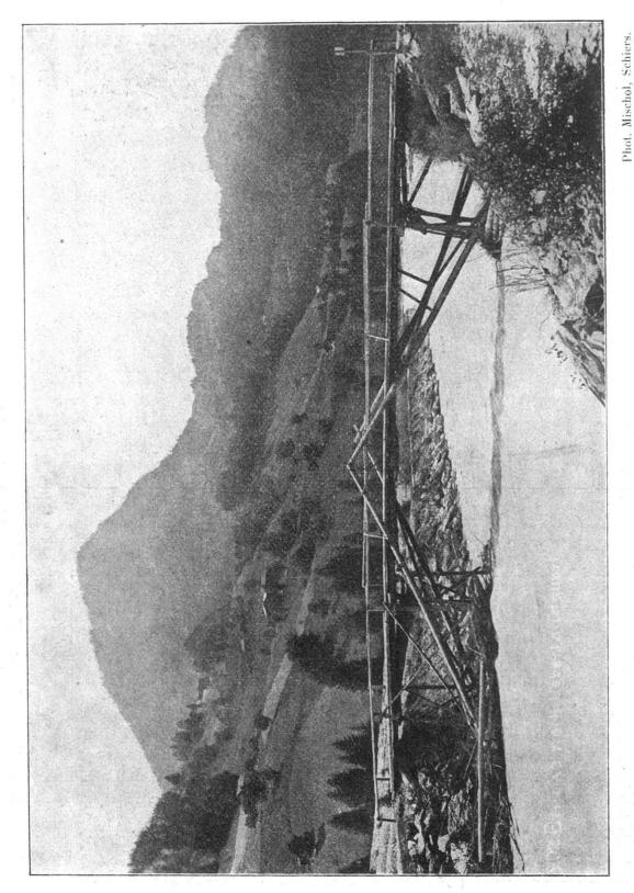
16. Pont de circonstance près de Prada. Ferme à arbalétriers remplaçant deux chevalets emportes par l'eau. Travées : 5+5+16+5=31 m. Barrages latéraux pour diriger les bois flottants sur l'ouverture centrale.
