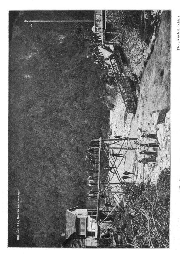
Longueur totale du pont une fois termine : 35,6 m. Portée de la ferme à contrefiches constituant le milieu du pont : 11 m. Hauteur des chevalets : 5,5 m. A droite viaduc des chemins de fer rhétiens, détruit.
