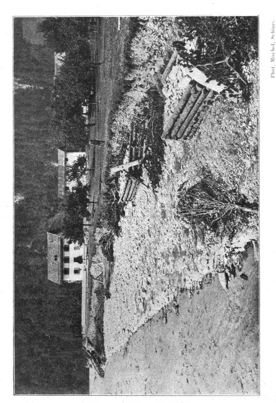
20. Le Schraubach en amont de Schiers. Caissons remplis de pierres, pour protéger les rives.
