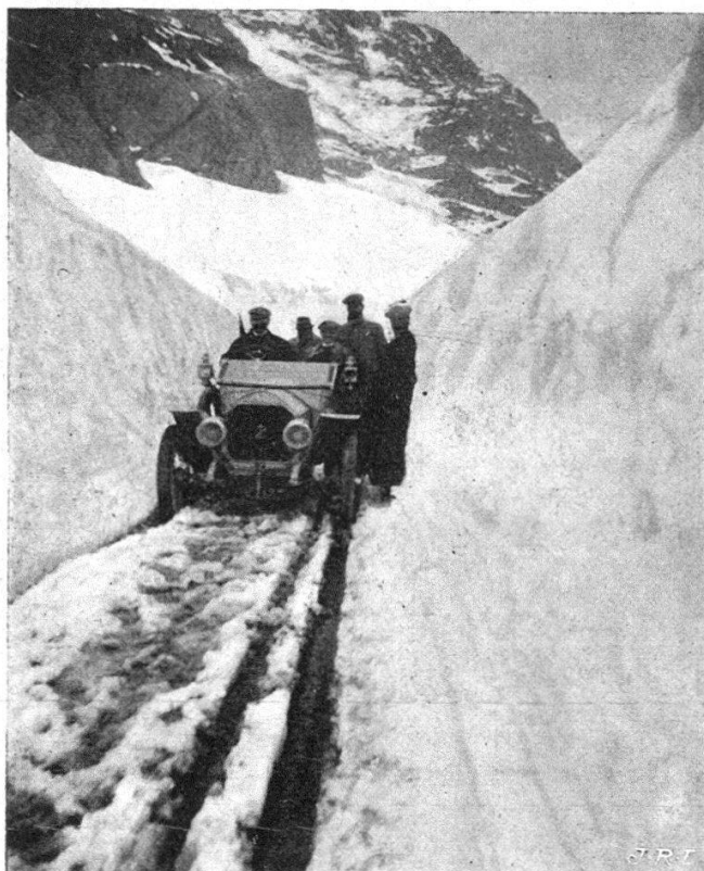
Dans la tranchée, à 1 km. de l'hospice.
