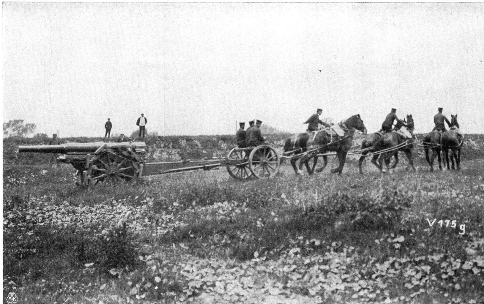
Canon de siège de 12 cm. Krupp L/35 avec ceinture pour roue. Roulage dans l'herbe mouillée.
