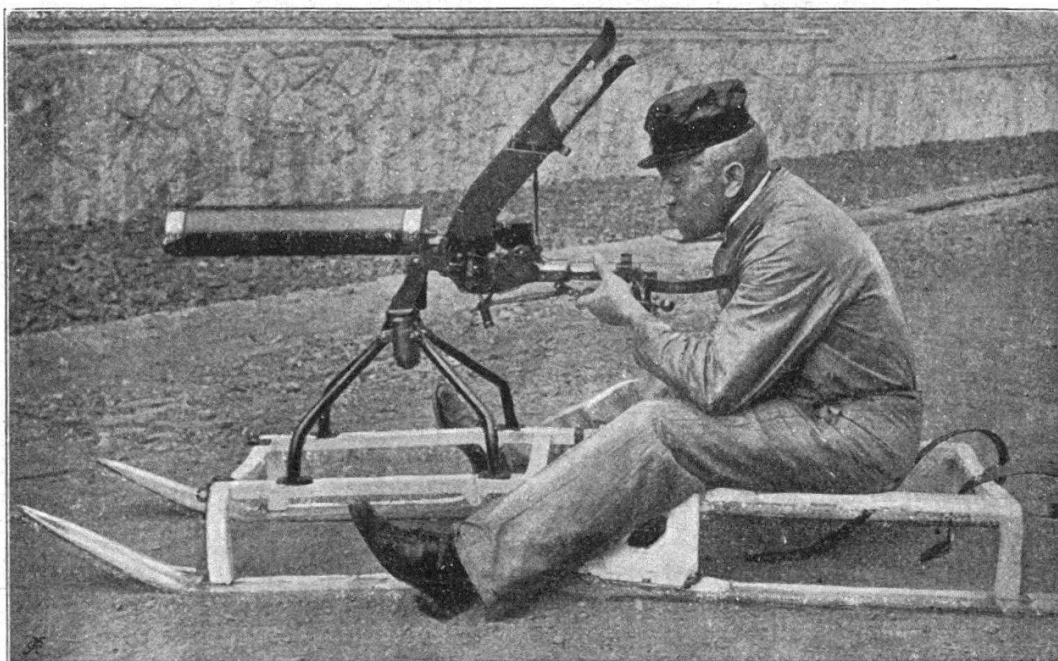
FIG. 1. — Traîneau de mitrailleuse sur skis sorti des ateliers Skoda.
