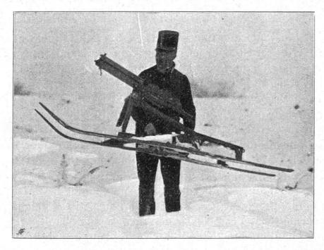
Fig. 3. — Traîneau de mitrailleuse sur skis, sorti de la fabrique d'armes de Steyr.
