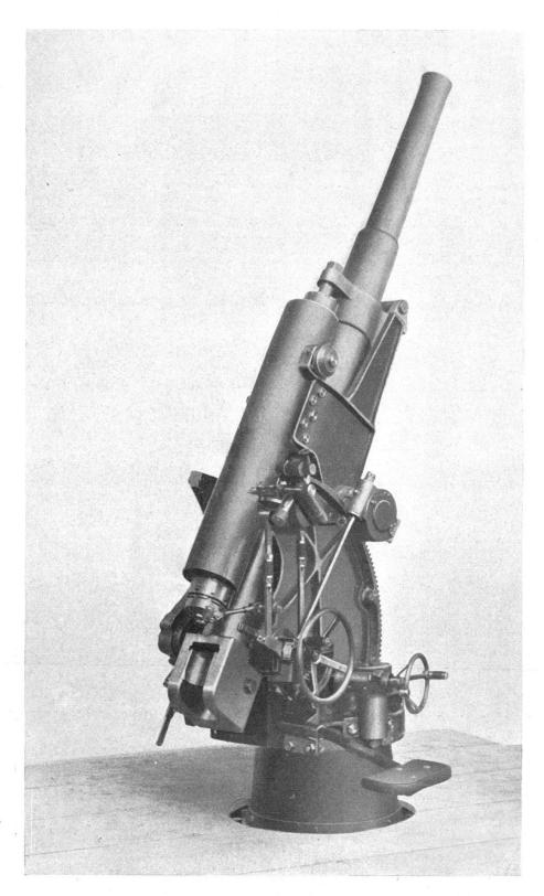
Canon de 7,5 cm. L/35 système Krupp, pour le tir contre les ballons, à frein pneumatique à lancée, sur affût d'automobile.
