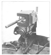
Mécanisme, la culasse étant ouverte.
