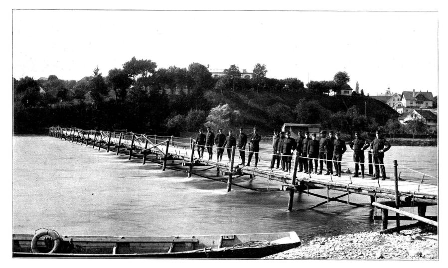
craignait que le pont, même réussit-on à le construire, manquât de stabilité. Cette année, sur la Limmat, on a ponté sans difficulté par environ 2 m. 70 d'eau et 2 m. 80 de courant et le pont était tout à fait solide.
