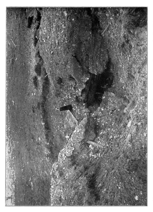
Même coup qu'à la pl. XII mais sur la traverse. Vue de l'entonnoir formé par l'atteinte qui a démoli l'abri. Dimensions de l'entonnoir: 3 m. de long, 3m5 de large, 1m5 de profondeur; volume déplacé environ 4 m³ (Cf. p. 343).
