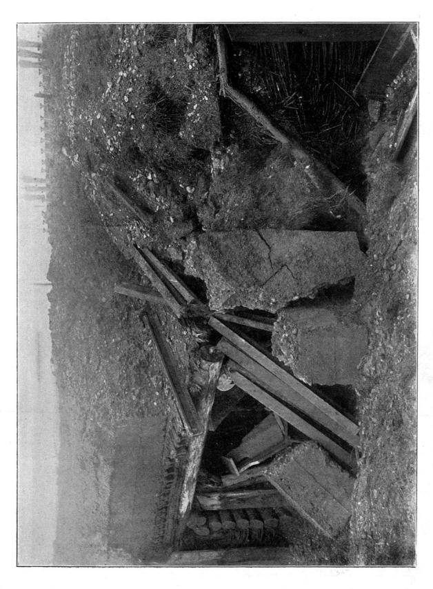
Effet d'un obus brisant sur l'abri avec couverture en béton (Cf. p. 343).
