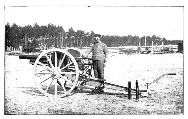
Fig. 2. — Canon Mod. 1901 avec affût à un cylindre.
