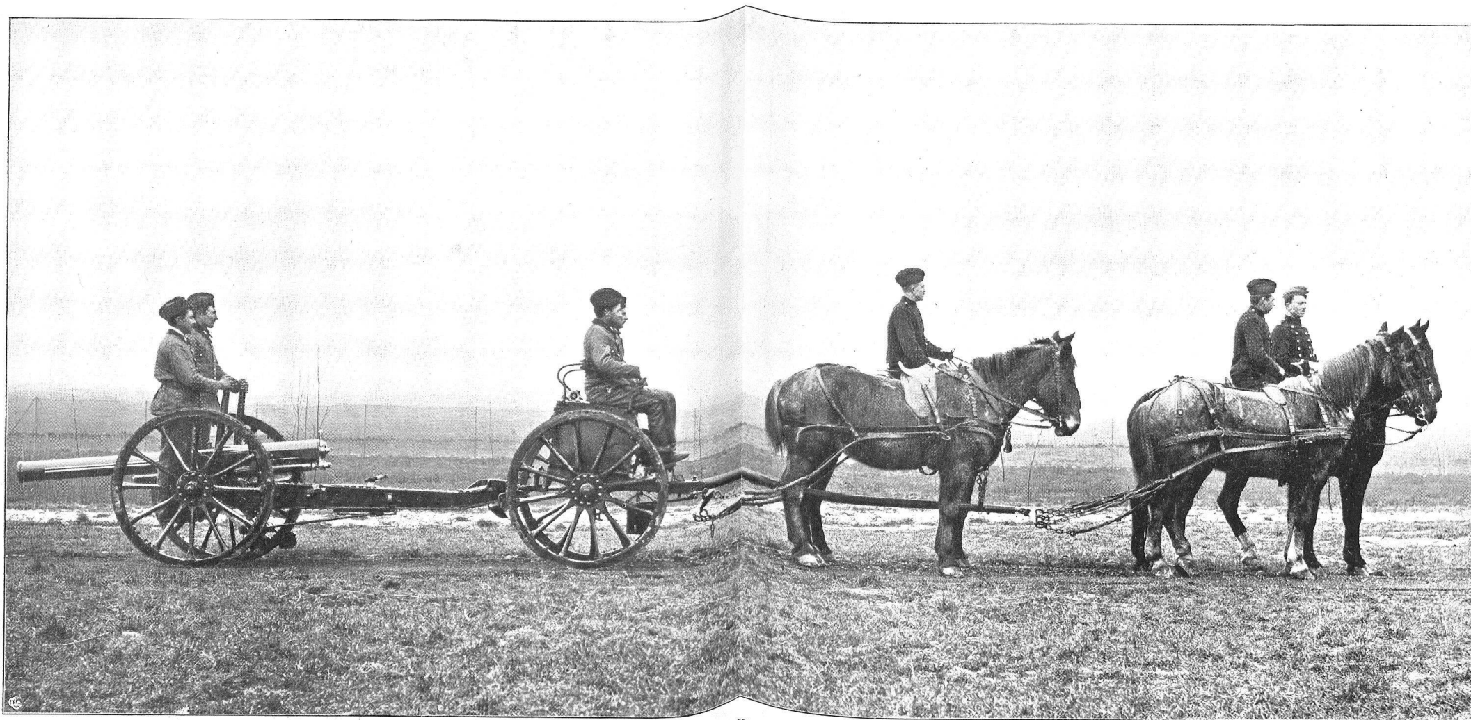
Canon de 75 mm de campagne à tir rapide, système Schneider-Canet. — Pièce attelée.
